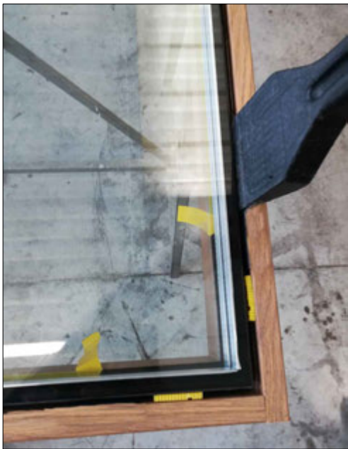
Inserire il vetro e procedere con lo spessoramento (vedi schema seguente)
