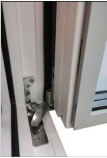
Cerniere a scomparsa per apertura anta a 105°
